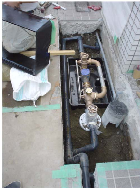
旧配管と切り離し
