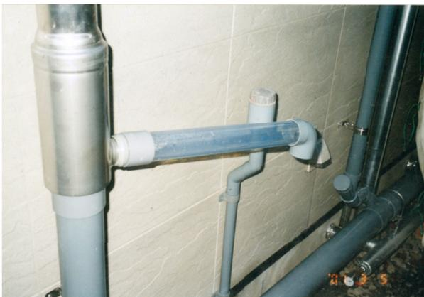
約120m<sup>3</sup>の屋上で集水された雨水は、降り始めの汚れた雨水を排除出来る雨水取水器により水質の良い雨水を地下タンクに呼び込みます。
