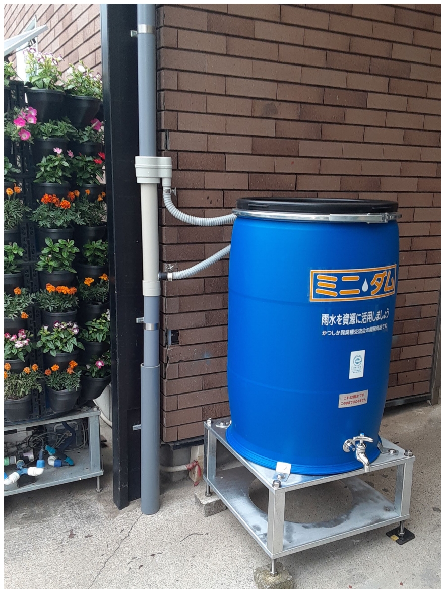
ミニダム200ℓ（自然循環方式：たてとい60φ）完成写真
